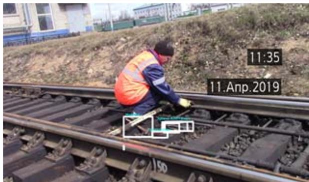
Рис. 3. Исходный кадр видео с отмеченными инструментами. Каждый инструмент в кадре помечен соответствующими координатами ограничивающей его рамки
