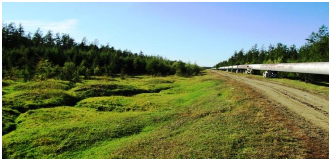
Рис. 1. Термокарстовые полигональные образования (объекты) на трассе водовода Лена – Туора Кюель – Тамта» (п. Майя, водхр. Мундуллах). Фото А. М. Сальва, 2016 г [1].
