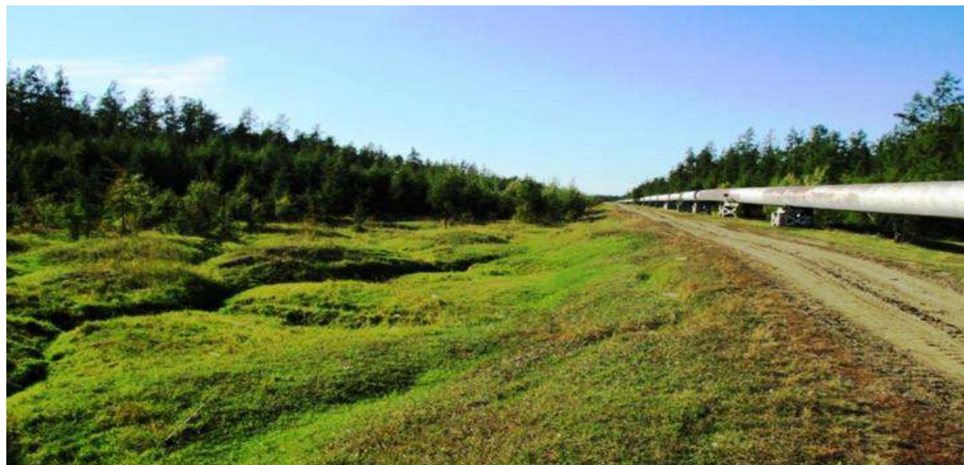
Рис. 1. Термокарстовые полигональные образования (объекты) на трассе водовода Лена – Туора Кюель – Тамта» (п. Майя, вдр. Мундуллах). Фото А. М. Сальва, 2016 г [1].
